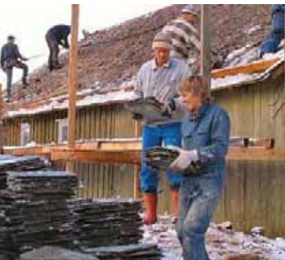
Restaureringen av Drøppingfjøset er i gang. En del av jobben ble utført på dugnad under mottoet: "Let's make Låve!"
