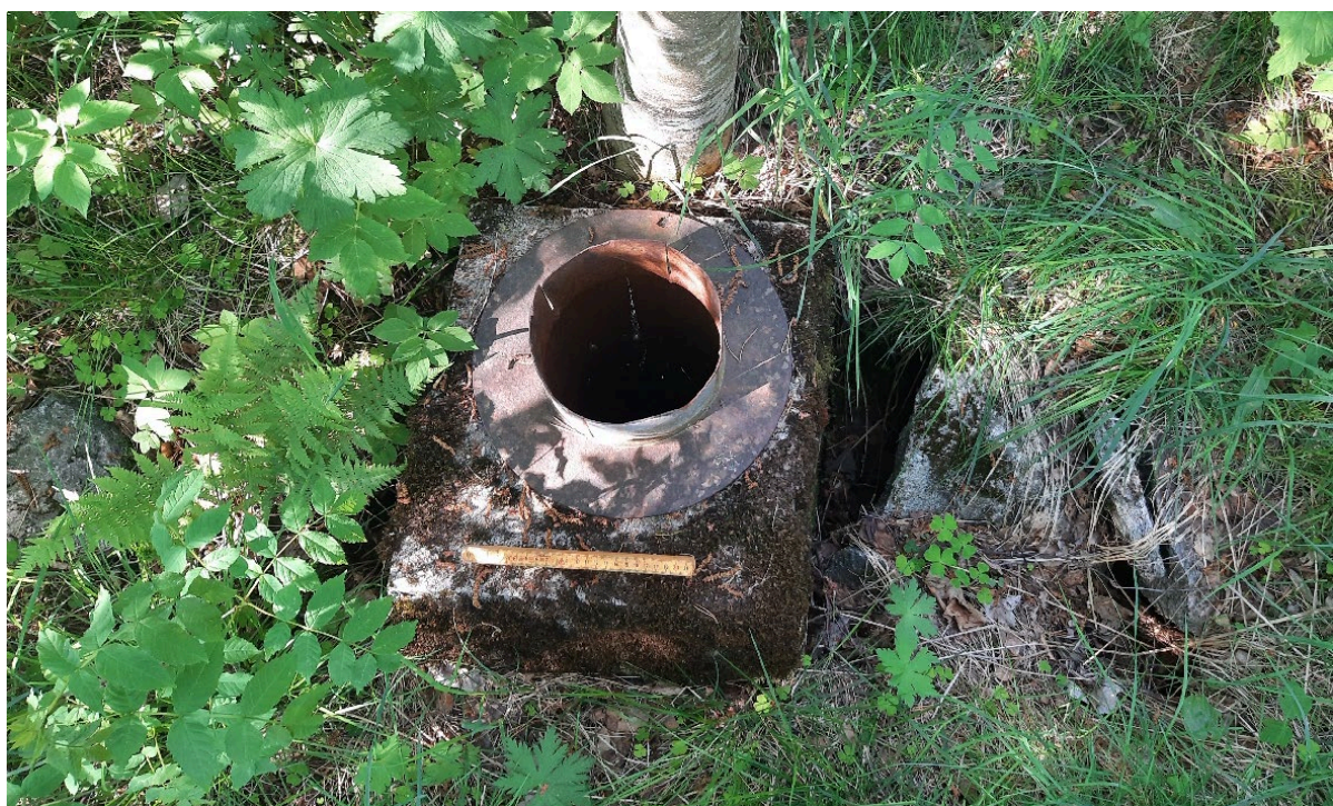
Figur 20. Luftehull bunker R 502
