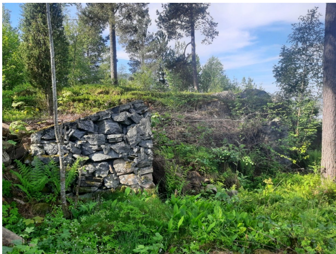
Figur 17. Steinkonstruksjon funnet ved overgang av området gbnr. 81/31 rett sør for planområdet.
