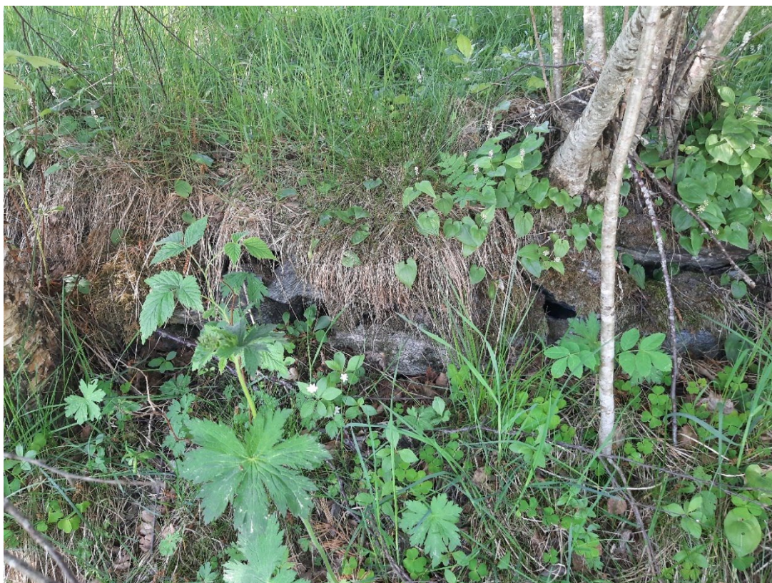
Figur 19. SV ytterkant av bunker R502
