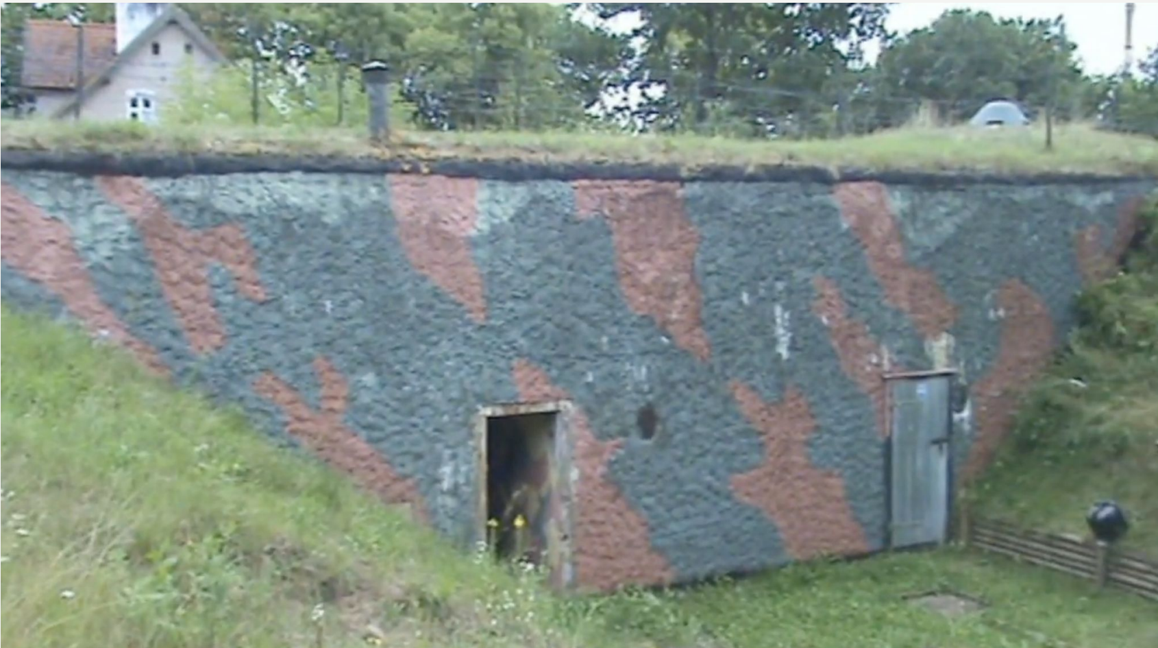
Fasade til bunker “Regelbau 502” i Pisz, Polen Kilde: youtube.com/watch?v=FoWrfGIGA18
