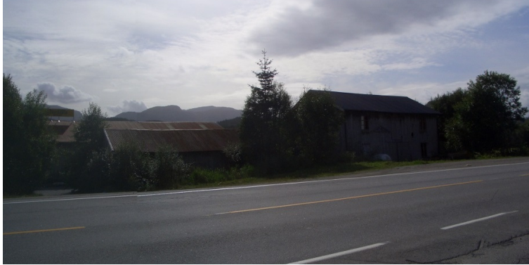
Figur 11: På østsiden av E39, nord i planområdet, ligger et gammelt nedlagt sagbruk. Panorama tatt mot SØ, sammensyningen er litt feil.
