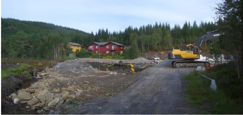
Figur 8: Barnehagen under utbygging. Selve bygningen skal ligge til høyre for gravemaskinen. Panorama tatt mot N.
