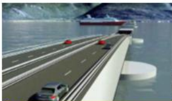
Flytebro+ undervannsrørtunnell. Statens vegvesen, utkast fergefri E39.
