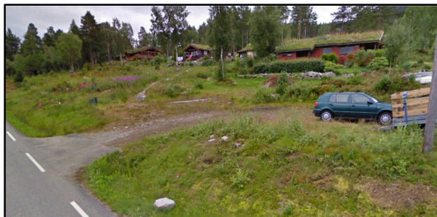
Foto fra Google maps viser de 3 vestligste av totalt 4 eksisterende bygninger på området, sett fra fylkesvegen. Eksisterende regulert felles p-plass i forkant.
